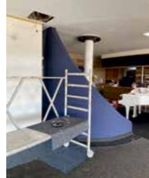
NEUER ANSTRICH IM RESTAURANT
